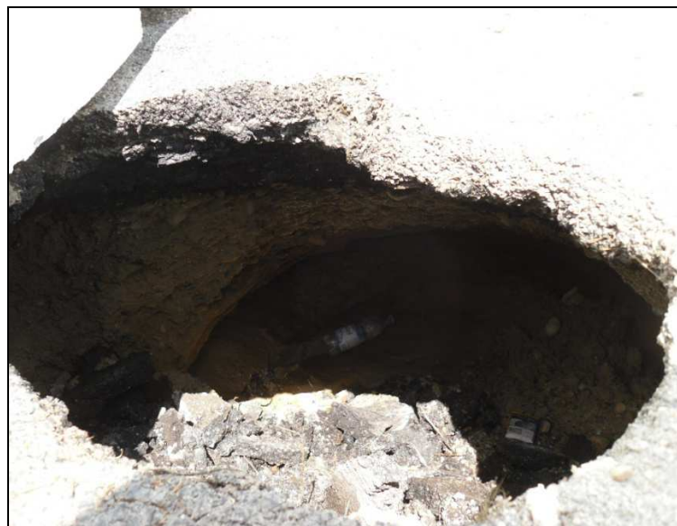
Fig.3: cedimento stradale in corrispondenza della spalla lato Robbio
