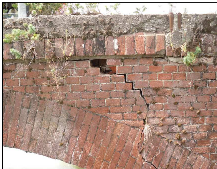
Fig.9: prelievo campioni di mattoni da sottoporre a prova. Da notare la significativa fessurazione spalla lato Robbio
