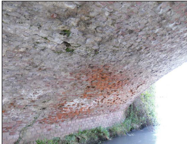
Fig.10: muratura intradosso arco lato Robbio. Da notare il significativo degrado della muratura costituente l'intradosso dell'arco
