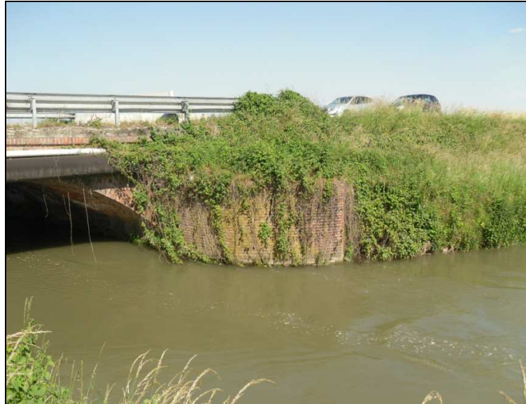
Fig.20: lesioni e danni strutturali al muro d'ala a valle in sinistra
