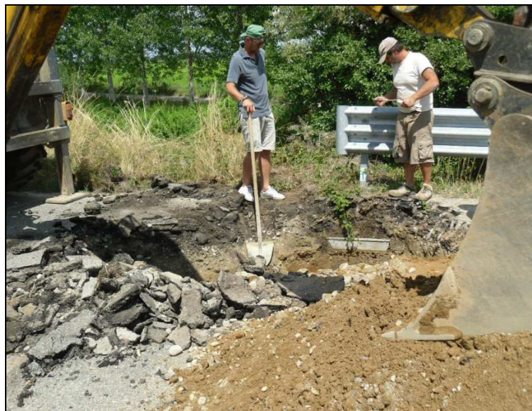
Fig.5: canalina Telecom in prossimità della spalla lato Confienza
