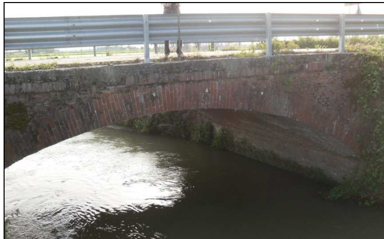
Fig.18: ammaloramenti e lesioni varie nella muratura verticale a monte
